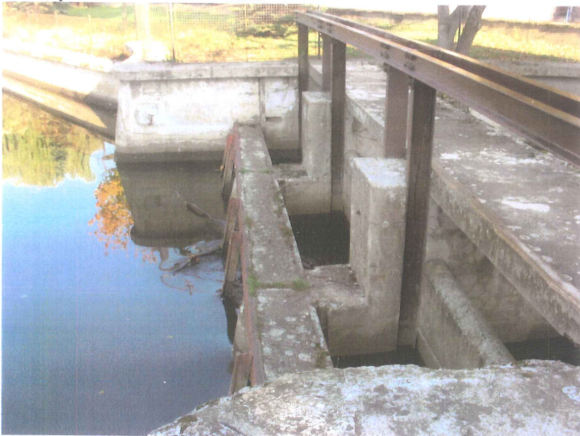
Vtok do přívodního kanálu na elektrárnu
