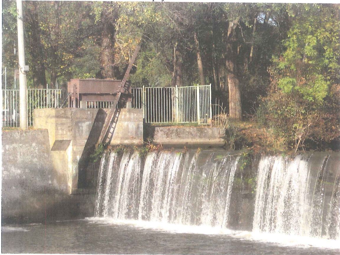
Vtok do přívodního kanálu na elektrárnu
